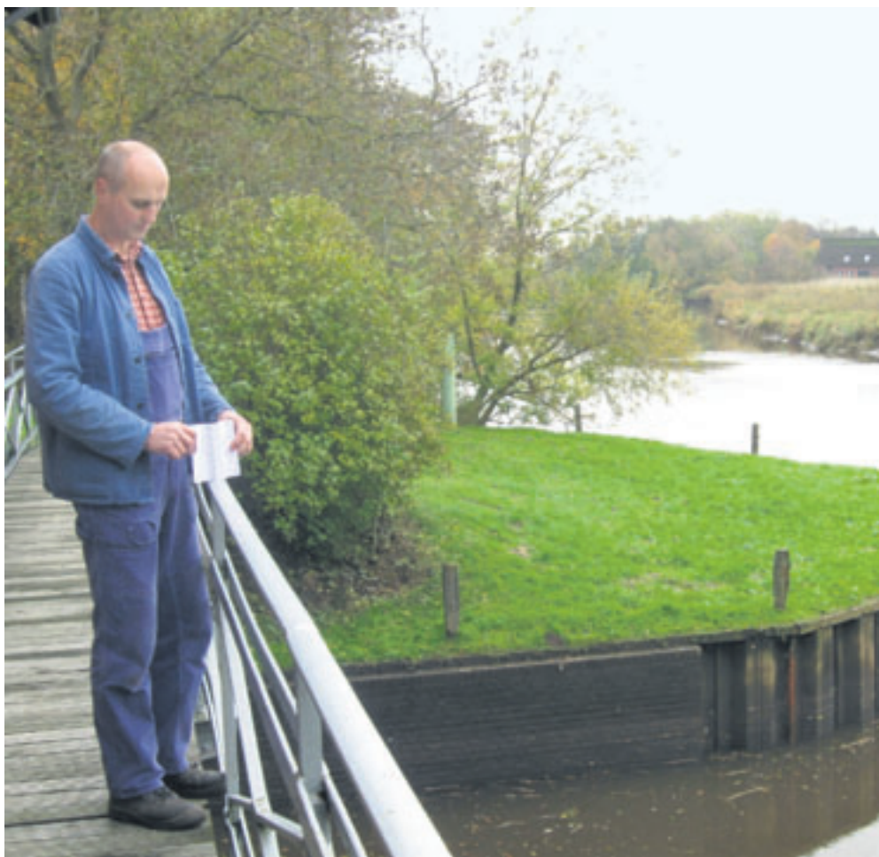
Der „Regisseur“ des Schöpfwerks Höftdeich, Hermann Helmken, bangt um die Haltbarkeit der Spundwände. Eine Sanierung soll 250 000 Euro kosten.
