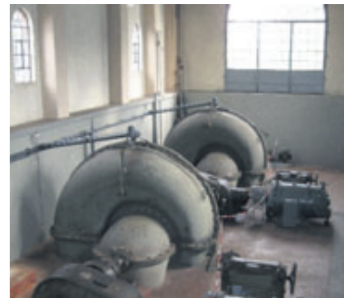
Die Pumpen sind weit über 100 Jahre alt und arbeiten noch immer zuverlässig.
