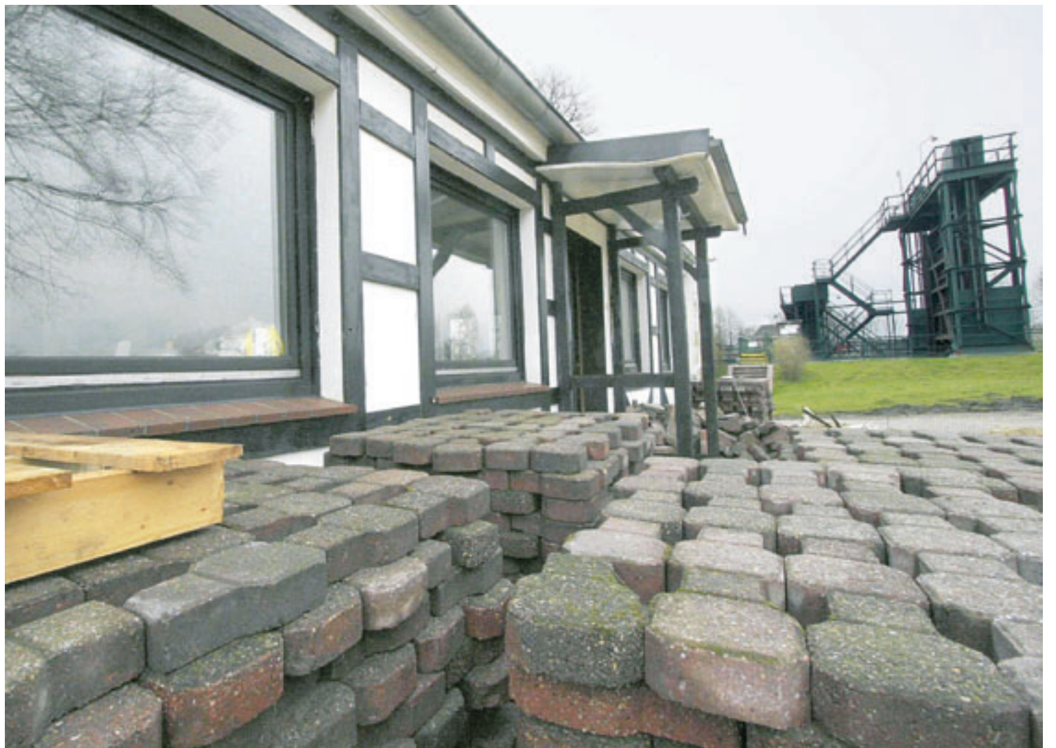
Die Pflastersteine des Parkplatzes sind bereits aufgeschichtet, jetzt soll es dem Schleusenwärterhaus mit der Abrissbirne an Kragen gehen. Dagegen wehren sich CDU, FDP und Grüne.
