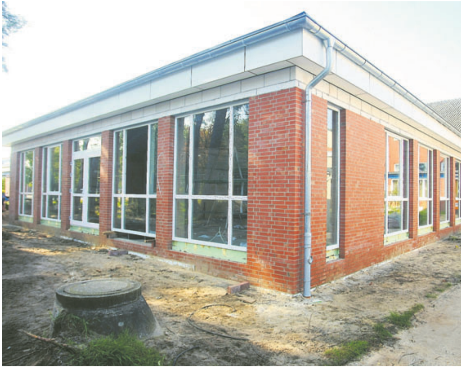
Der Bau der neuen Mensa (Bild) für den künftigen Ganztagsbetrieb an der Heideschule ist schon weit vorangeschritten. Im November legt die Schule mit einem Notdienst für 20 Kinder los – im Februar 2012 startet sie richtig durch. GKE-FOTO: CHRISTIAN KOSAK
